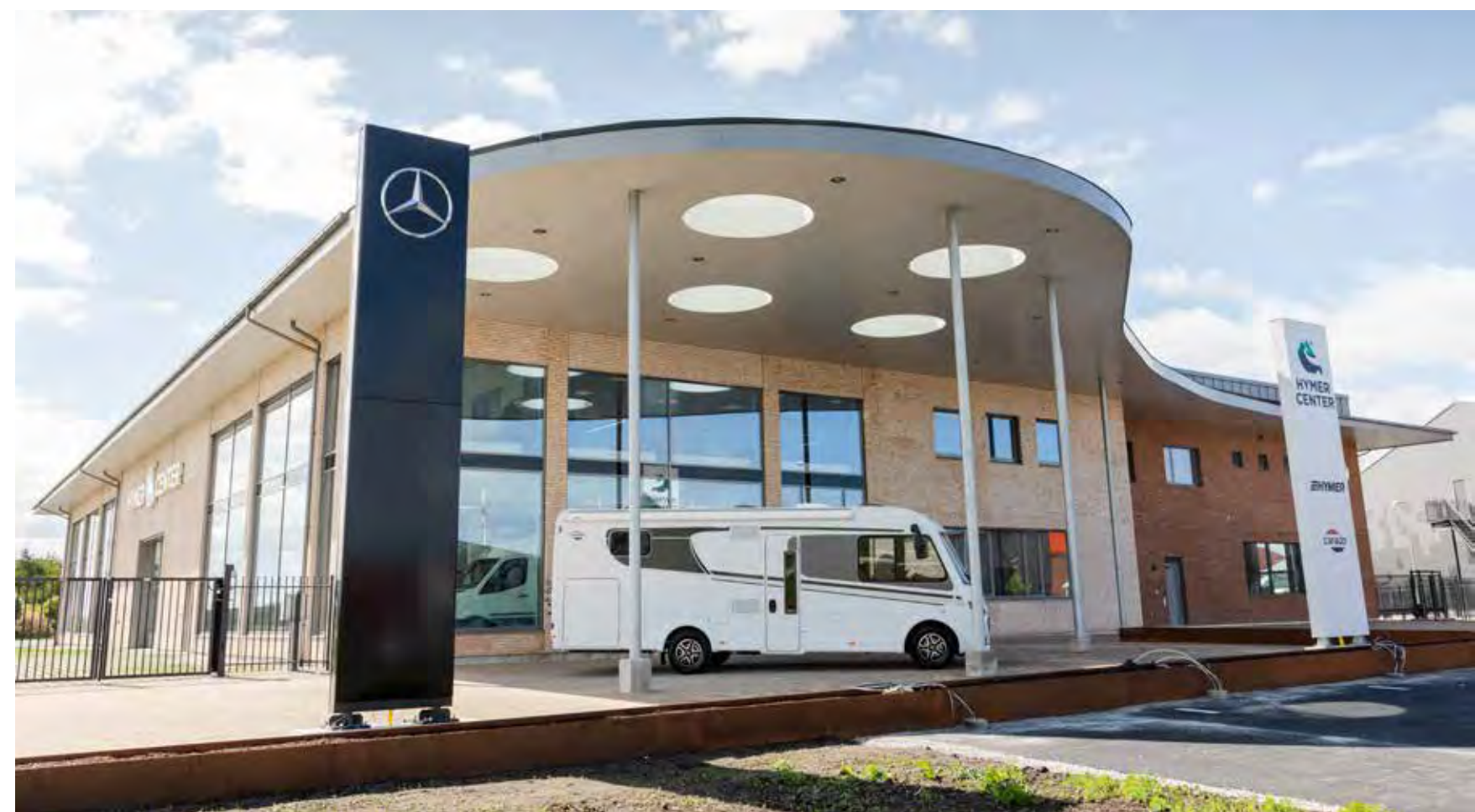
En unik siluett med skärmtak, tegelfasad och stora glaspartier.
